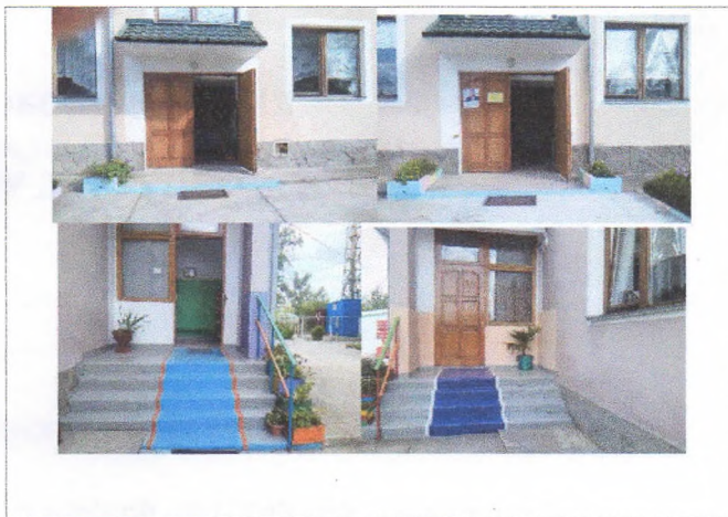
Фото №2 – Вход в здание
